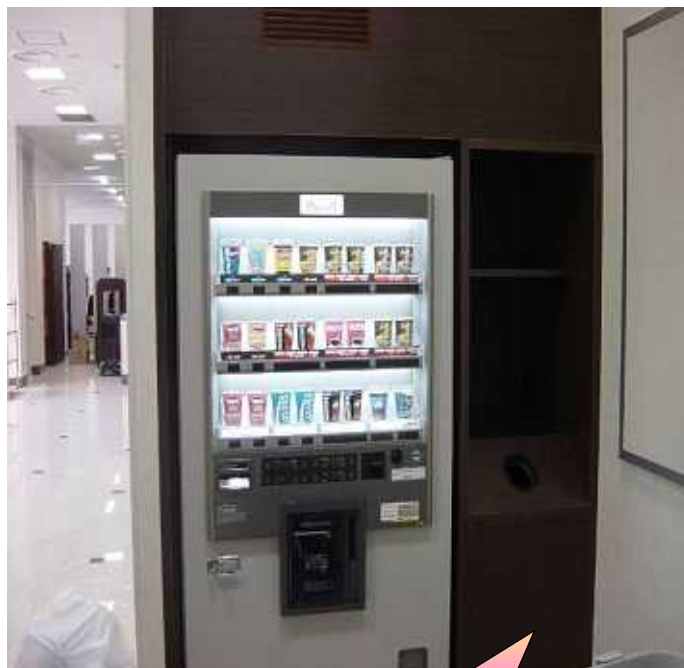
スペースを全体仕舞いしており、湿気がこもり易いロケ先の為にルーバー(通風孔)を取り付けるなど問題点を解消した設計で施工しております。
