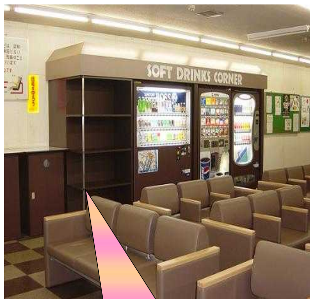
一番左側にはロケ先のご要望でファイル(回覧板等)を収納できる棚を製作しております。また 移設が容易に出来るように解体、組立を考慮した設計で施工しております。
